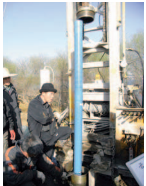
Pegelbohrung in Korea soll geeignete Standorte für Uferfiltrationsanlagen ausloten. © IGÖ
