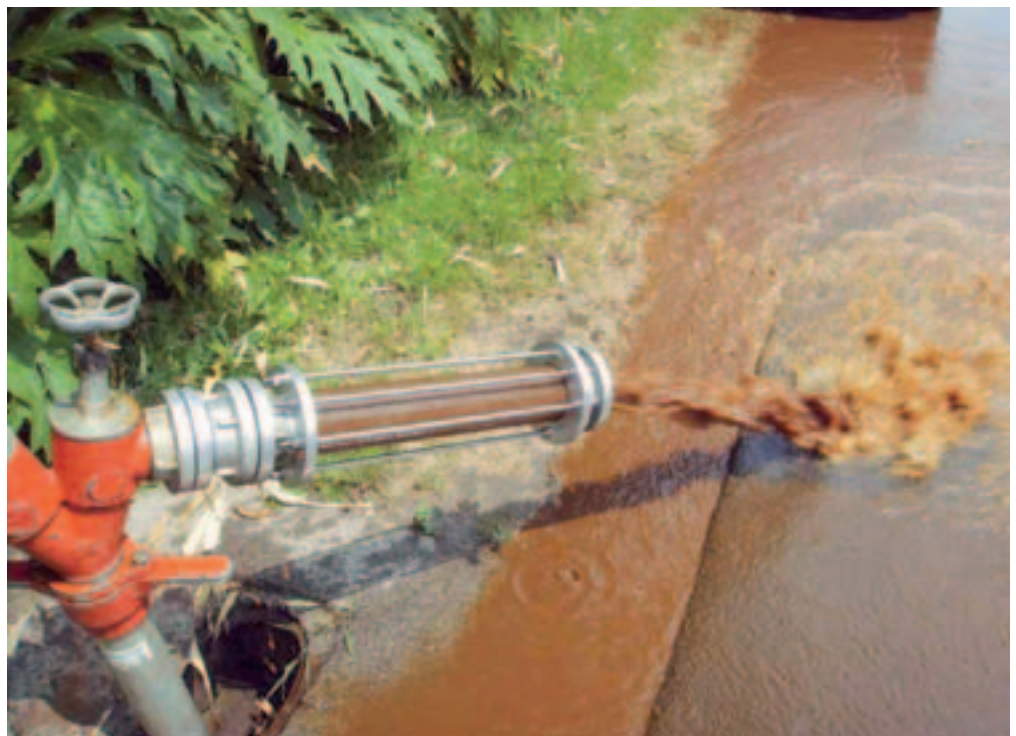
Bild 1. Ausspülung einer Reinigungsstrecke des Trinkwassernetzes. © Hammann/Gutjahr
